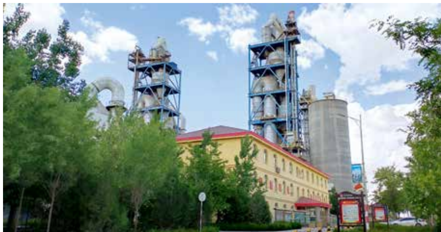
太阳山分厂中控楼
