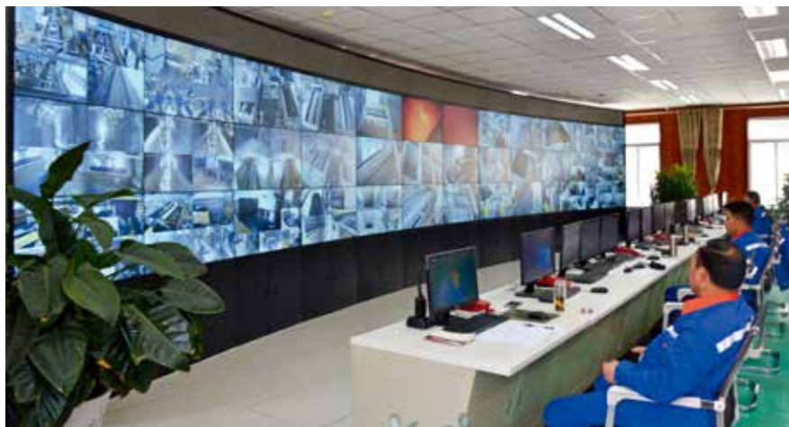
祁连山水泥生产调度系统
