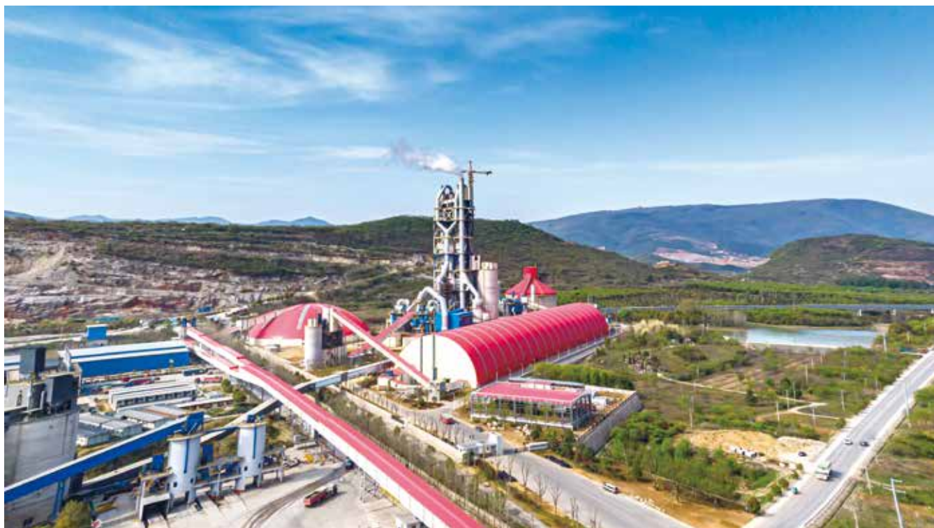
槐坎南方日产7500吨优化升级项目全景
